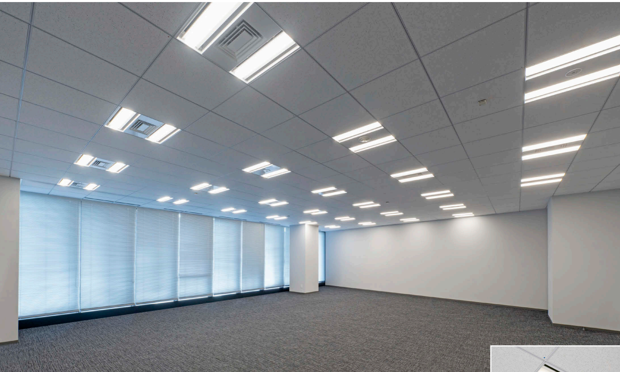
貸室（入口側から望む）天井高 2,800mm の無柱空間にシステム天井用器具グリッドタイプ①を採用することで、より広々とした空間を創出。
