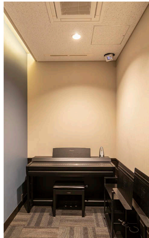
(左)第8レッスンスタジオ・(右)第6レッスンスタジオ 個人レッスンに適したコンパクトなスタジオにも、部屋中央部に照射角度を合わせてUVeeユニバーサルダウンライト①を配置し、有人モードで運用。
