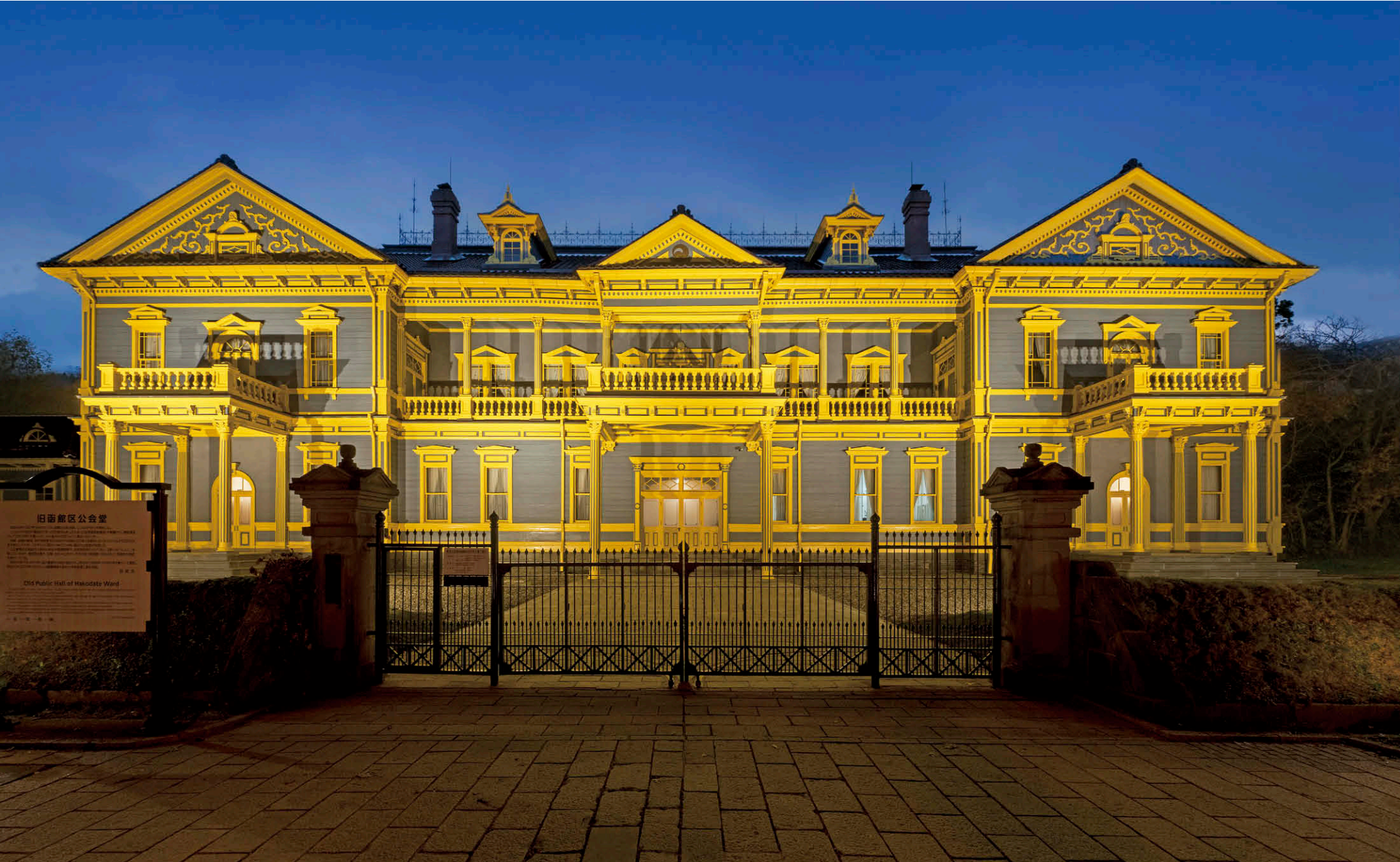
建物正面からのライトアップ風景 既存器具に換えて3000KのLED小形投光器①を計10台採用。バルコニーや柱の影までが外壁の美しさに調和。
