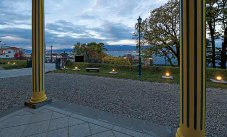
器具設置状況 前庭をはさんだ道路側に計10台のLED小形投光器①を設置。
