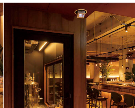
通路 トイレへと続く狭い通路のため、壁面も照射できるようにUVecユニバーサルダウンライト①を配置。
