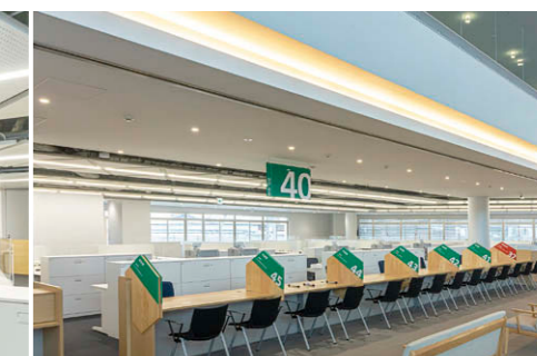
カウンター 4000KのLED小径ダウンライト②により執務室と色温度を揃えながらやさしい光環境に。
