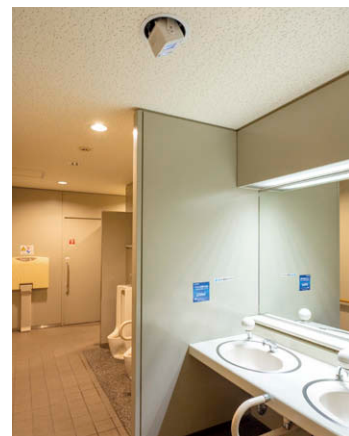
1階男子トイレ UVec①を洗面コーナー天井に設置。
