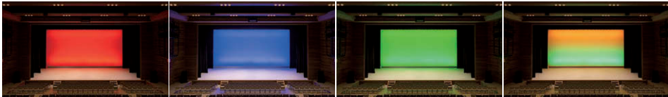
水平ライト アッパー、ローアともに5色タイプのLED水平ライト⑤⑥を採用し、多彩な色彩表現が可能。
