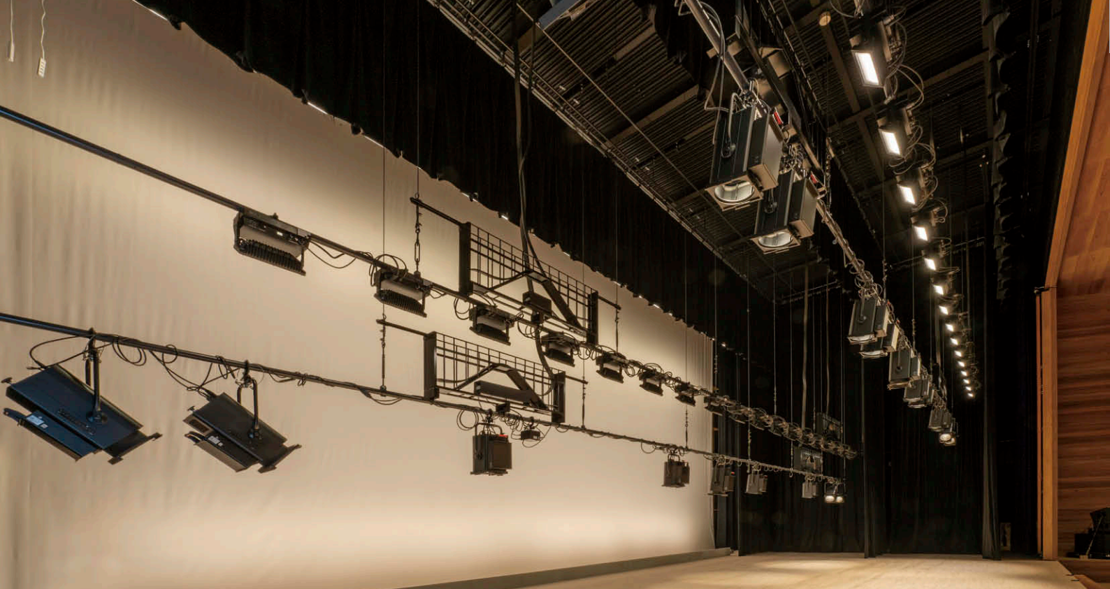
多目的ホール(ステージ) LEDスポットライト③④のほか、5色タイプのLED水平ライト⑤をボーダーライトとして採用。 市民利用の際にも簡単にフルカラーの演出が可能。
