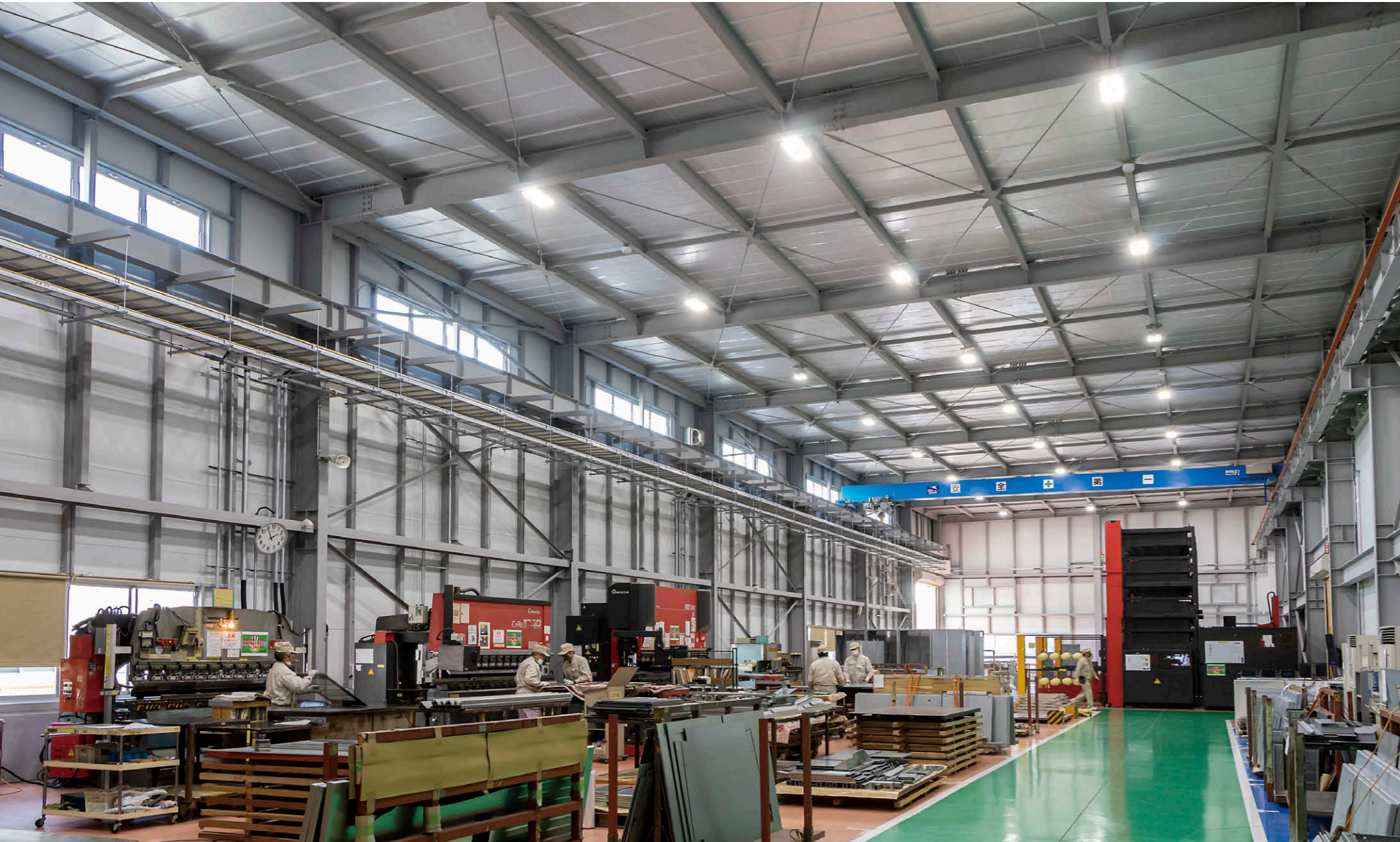
板金工程の照明風景 カメラ付きLED照明ViewLED①とLED高天井器具②③を計30台整列配置し、明るく作業しやすい照明環境を創出。
