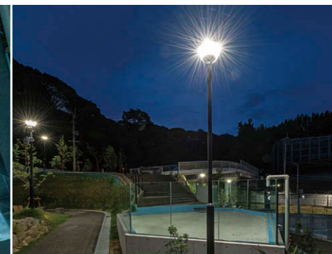
ペンギン岬付近の照明風景 見学ルートにはポールも合わせて指定色に塗装したLED街路灯②を12台設置。
