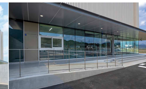
エントランス前 5000Kの軒下用LEDダウンライト⑤を8台採用。
