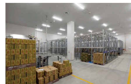
製品倉庫 高さ6mの天井面にLEDベースライト①35台を整列配置。
