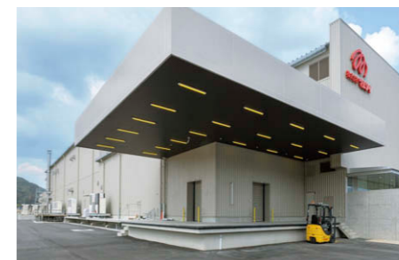
トラックヤード イエロー光LEDパーの低誘虫タイプ④を21台採用。
