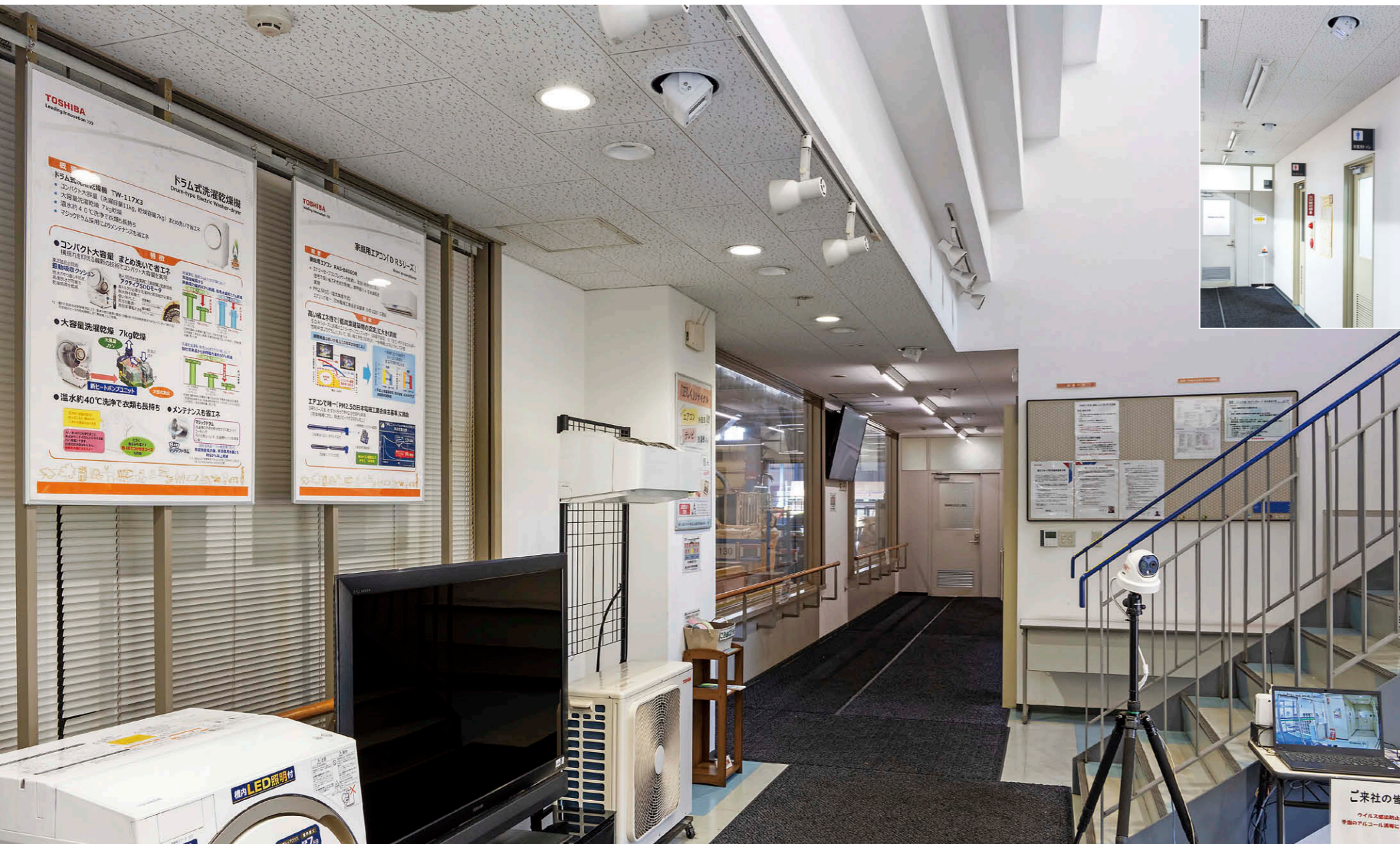
工場棟1階ロビーおよび見学者通路 ロビーの検温機まわりに向けて1台、見学コースの手すりに向けて4台のUVeeユニバーサルダウンライトタイプ①を設置。
