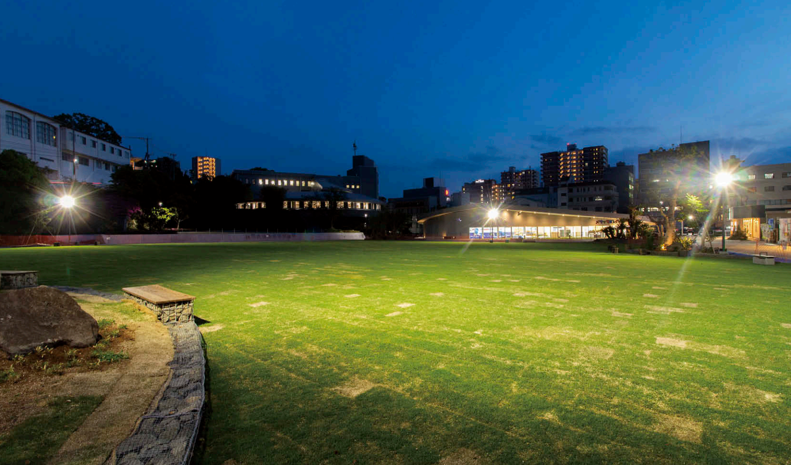
芝生広場の照明風景 計 8 台の 250W 形水銀ランプ器具相当 LED 小形角形投光器広角タイプ③により最大で約 60 ルクスの照度を確保。
