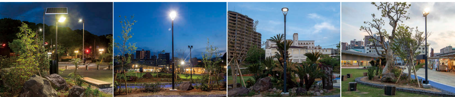
芝生広場まわりの屋外照明 島を模した植え込みに埋込式ポールによる照明灯を設置。写真は LED ソーラーライト② (左)、LED 街路灯① (中左、中右)、LED 小形角形投光器③ (右)。
