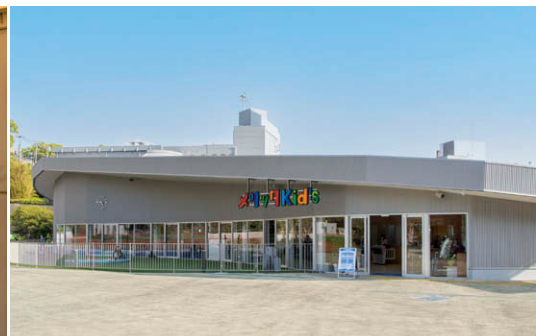
屋内遊び場外観 外壁も屋根も曲面的につくられた1枚屋根構造のメリッタKid'sSASEBO。
