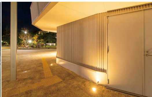
屋内遊び場外縁 地中埋込形のLED投光器⑤により外壁面と軒をライトアップ。
