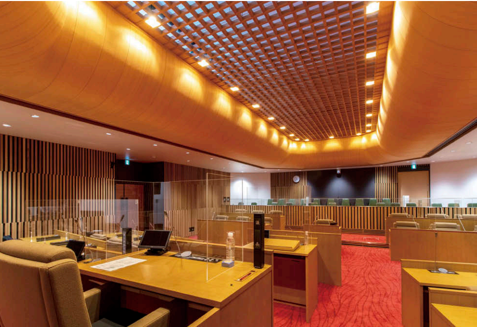
本会議場 天井の格子内にLEDユニット交換形ダウンライト⑦を配置しやさしい陰影を創出。周辺部にはLED一体形ユニバーサルダウンライト⑧を採用。
