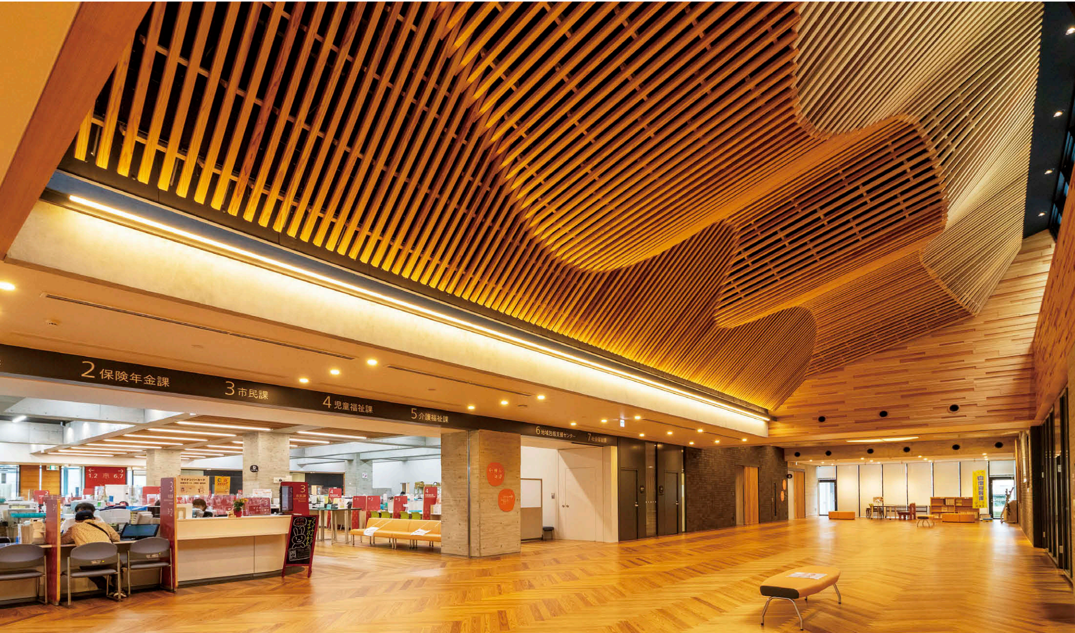
五條モール 金剛山の山並みをイメージした天井の造形をより際立たせる間接照明として、3000KのLEDベースライトTENQOOシリーズ①を採用し、立体的で暖かみのある空間を創出。
