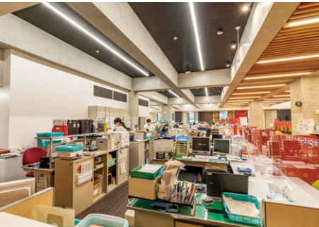
1階執務室 LEDベースライトTENQOOシリーズ④に加え、カウンター上部にLEDユニット交換形ダウンライト直付シーリング②を配置し照度を確保。
