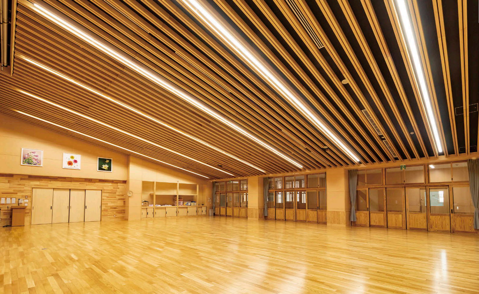
多目的教室 木製ルーバーが入った斜め天井の意匠を引き立たせるように直結で配置された LED ベースライト②
