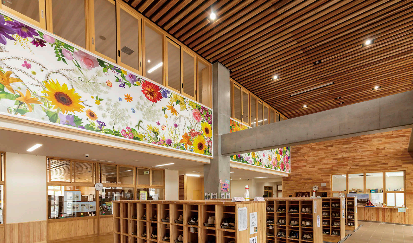
昇降口 天井ルーバーの間に LED 一体形ダウンライト⑨を配置。
