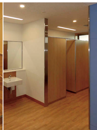
トイレ 明るさに配慮したLEDベースライト⑤とLEDユニット交換形ダウンライト⑧の照明。
