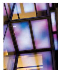
発光部が等間隔(100mmピッチ)でヒモ状に連なったiColor Flex MX gen2①を、50mmピッチに縮めてパネルに組み込み、フルカラー演出ができる発光面を構成。
