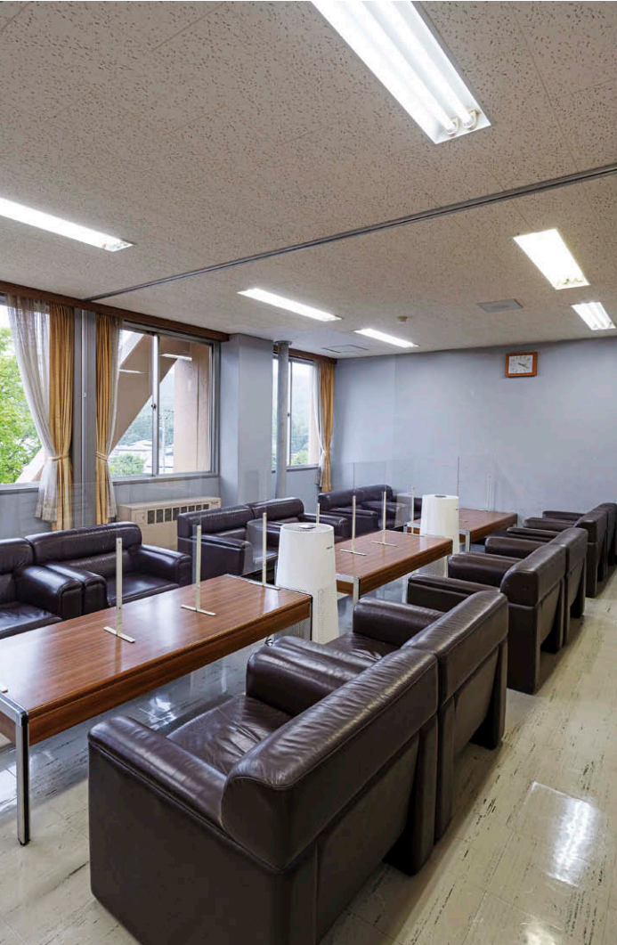
3階議員控室 UV-C室内空気除菌機②を2台導入。
