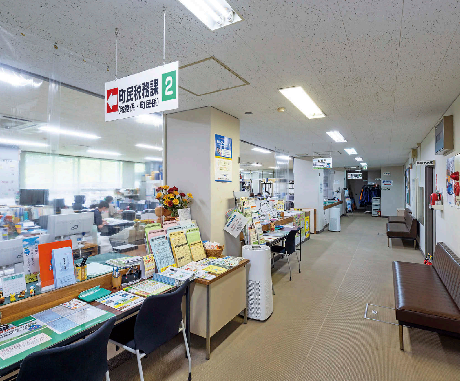
1階町民税務課窓口前 カウンター手前の来庁者スペース側に2台、カウンター奥の執務スペース側に2台のUV-C室内空気除菌機②を設置。
