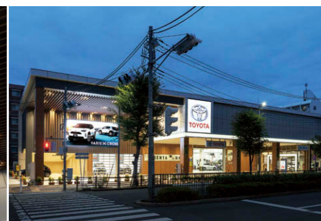
薄暮の外観 大型LEDビジョン、明るい軒先、夜間展示でアピール。
