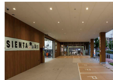
車路 LED一体形ダウンライト①による照明。
