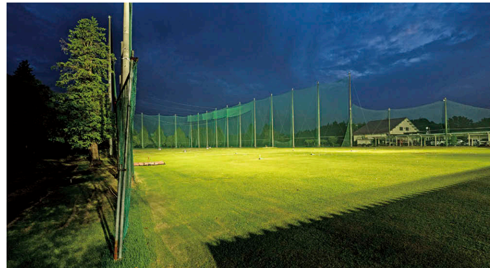
打席横側から望む 主に狭角形のLED投光器①②③を用いて練習場の外には光が漏れないよう配光を綿密に設計。
