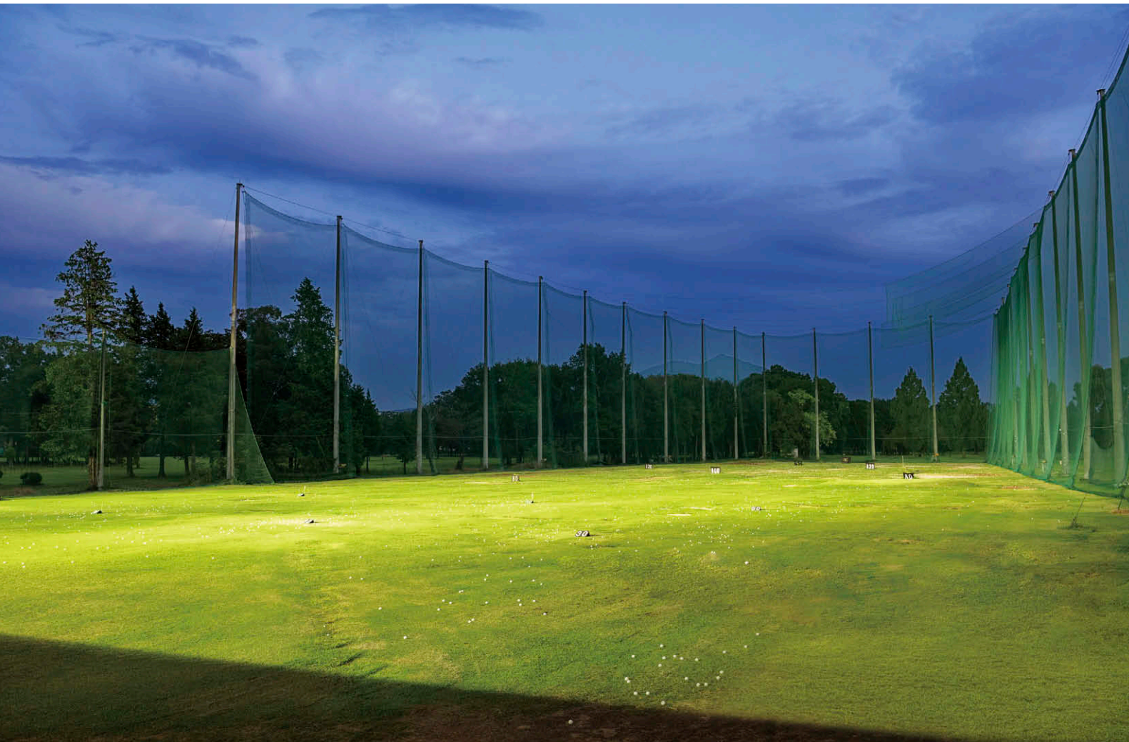
打席側から望む LED投光器メタルハライドランプ1kW相当①②③を採用し、明るく快適な夜間練習環境を創出。
