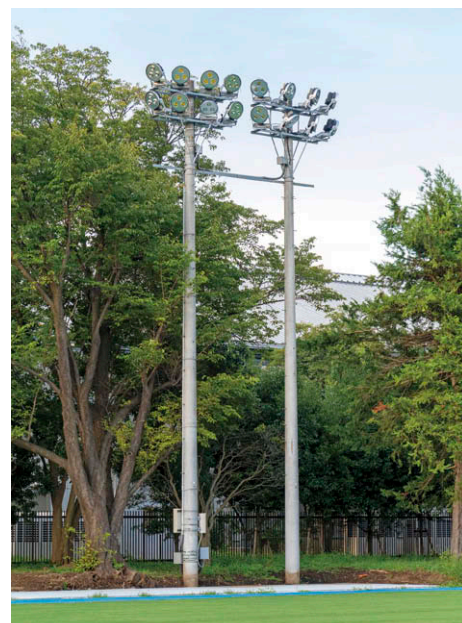
照明柱を2本柱1基として1カ所に16台のLED投光器①②を設置。
