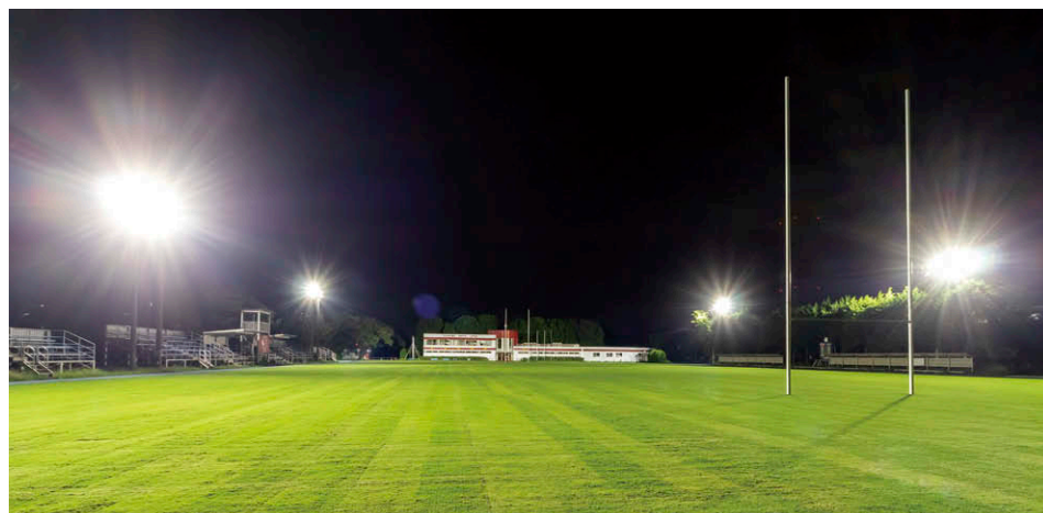
天然芝グラウンド LED投光器①②を64台採用し、均斉度の確保されたグラウンド照度を実現。
