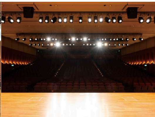
ステージから客席を望む (左) 昼白色の壁面間接照明TENQOOシリーズ⑤100%点灯時。 (右) LEDスポットライト⑥⑦および壁面間接照明のDC LED電球④を点灯。
