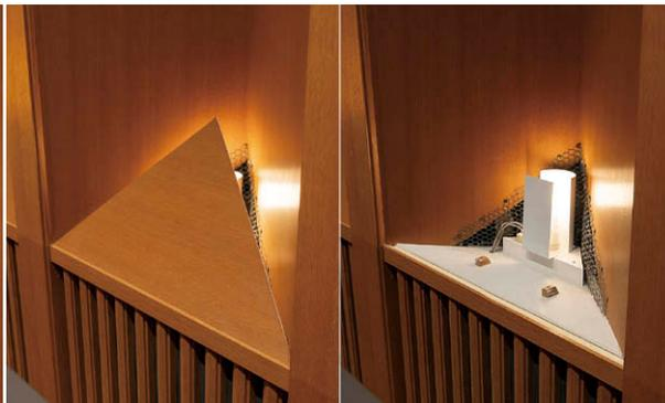
下部間接照明 LEDシアターシリーズ電球システム、DC LED電球④を設置。(左)目隠しあり(右)目隠し内部。
