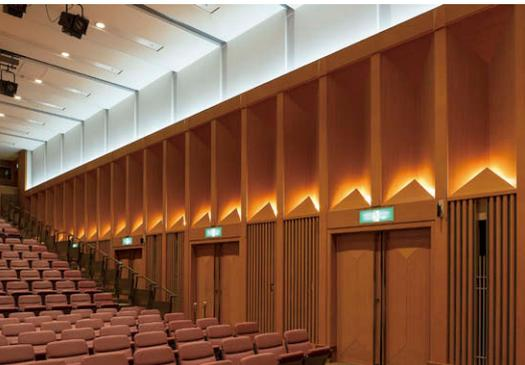
壁面間接照明 上部はTENQOOシリーズ⑤を、下部はDC LED電球④を既設器具位置に設置。
