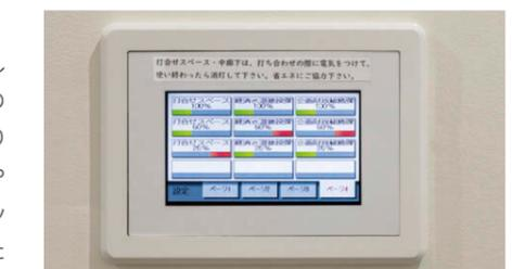
液晶タッチパネル エリア別にシーン選択が可能。ページ1~4の中で後からのレイアウト変更も可能。
