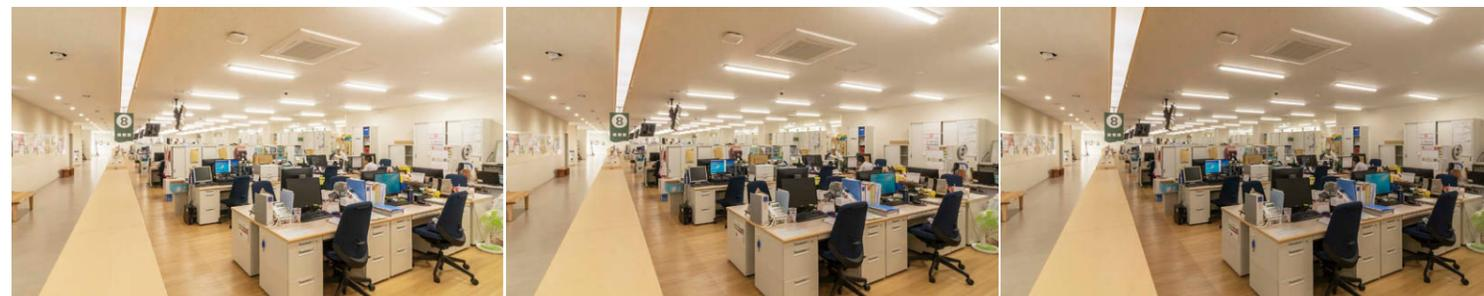
2階執務スペースの照明制御 左から100%点灯(750ルクス)、50%点灯(500ルクス)、25%点灯(300ルクス)でLED器具①②をシーン設定。
