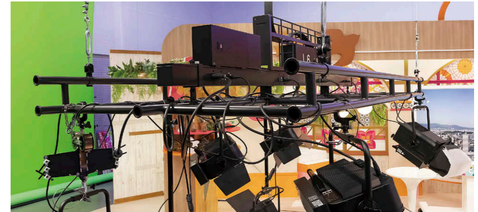
トラスバトン 3,325×1,350mmのトラスバトン(8掛)は、センターにセンビを配置した2段パイプ構造の軽量設計で、8ポートノードを搭載。
