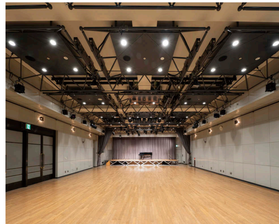
むらさきホール 既設グリッドにLEDシアターシリーズダウンライト②を、既設ブラケットにLEDシアターシリーズ電球システムDC LED電球③を採用。
