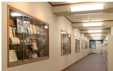
1階中学教室前廊下 展示スペースの演出としてLEDブラケット⑪を梁部に設置。
