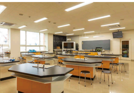
第2理科実験室 15台のベースライトと2台の黒板灯を更新(④⑩)。
