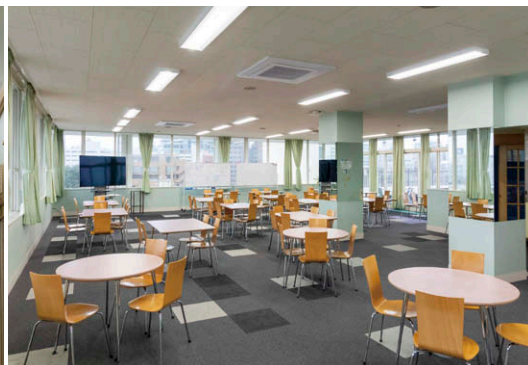
6階ペントハウスラウンジ 直付下面開放タイプのLEDベースライト④に更新。
