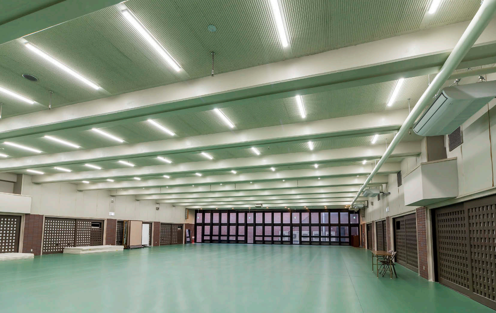
サブアリーナの照明風景 4,000lmタイプの直付形LEDベースライト②を計90台、窓側に電球色のLEDユニット交換形ダウンライト③を13台採用。
