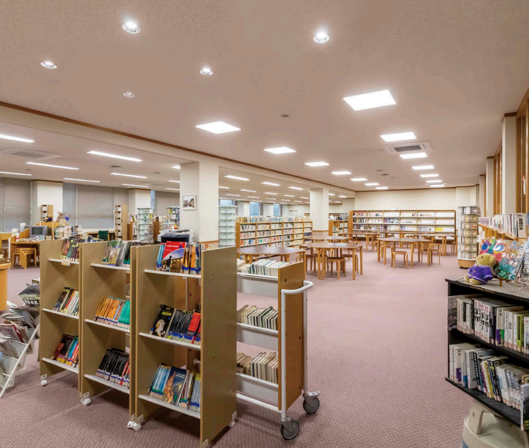
図書室 LED一体形スクエア⑤、LEDベースライト⑥、LEDユニット交換形ダウンライト⑦に更新。
