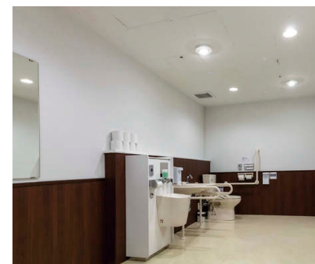
多目的トイレ 照明付のUVish天井埋込タイプ①と一般照明のダウンライトを併用して配置。
