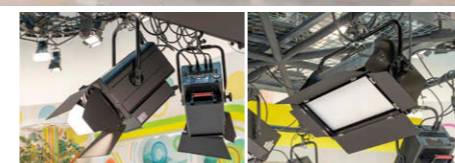
LEDスポットライト①② LEDブロードライト③
