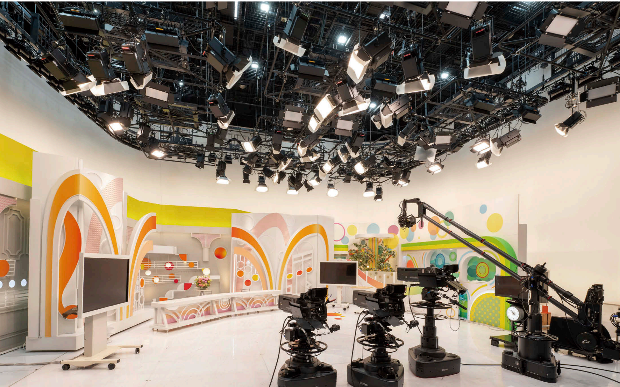
Aスタジオ 夕方の帯番組「アップ!」セット時。スタジオ左側に組まれたセットに対してLEDスポットライト①②、LEDブロードライト③をセッティング。
