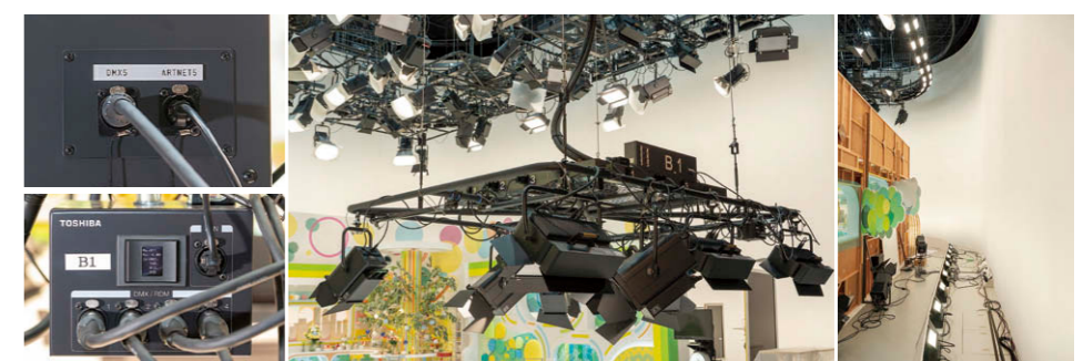
トラスバトン(Aスタジオ) 既設バトンにDMXとイーサネット™のコネクタを増設し、LEDスポットライト①②、LEDブロードライト③に対応。 LED水平ライトアップ④ローア⑤
