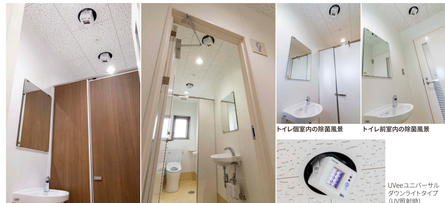
職員用トイレ(左)と調理員用トイレ(右) トイレは個室と前室に洗面台が設けられ、それぞれにUVeeが紫外線を照射。
