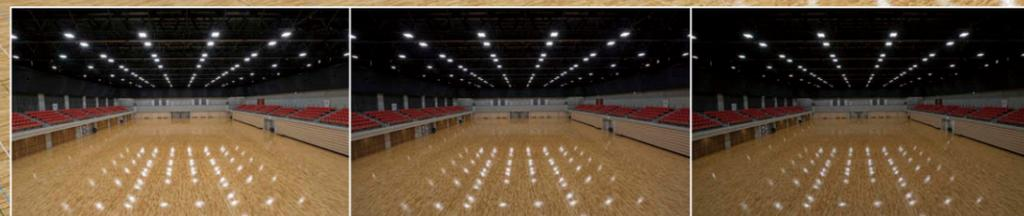
メインアリーナの照明 高さ13.5mの天井にLED高天井器具(特注品)①②を8列で配置し均斉度の高い照明環境を創出。100%全点灯(大写真)のほか、75%点灯、50%点灯、25%点灯(下写真左から)の照明環境も創出可能。
