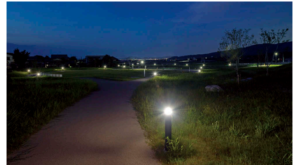
芝生広場の照明 園路およびジョギングコースに沿ってLEDガーデンライト⑥を配置。
