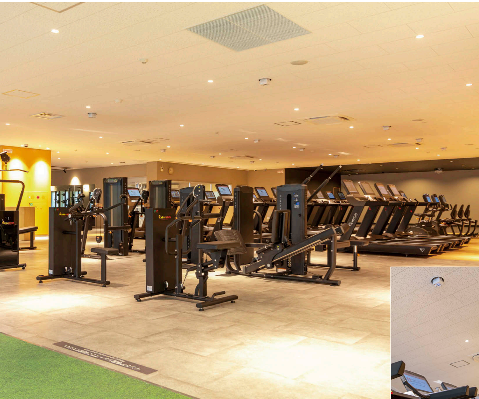
ジムエリア 高さ2.9mの天井に、UVeeユニバーサルダウンライトタイプを21台配置。
