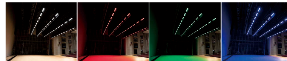
第1ホール(舞台上) フルカラーLEDポーターライト②により色彩豊かな照明演出が可能。
