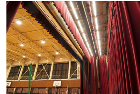
津名東小学校体育館の舞台照明 調光タイプのLEDベースライト④を8台×2列で配置。
