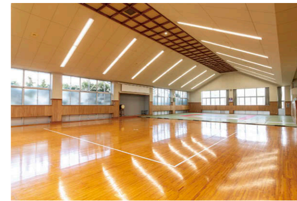
津名体育センター武道館の照明 110タイプのLEDベースライト⑥を採用。天頂部の水銀ランプ器具はLEDダウンライト⑦に更新。
