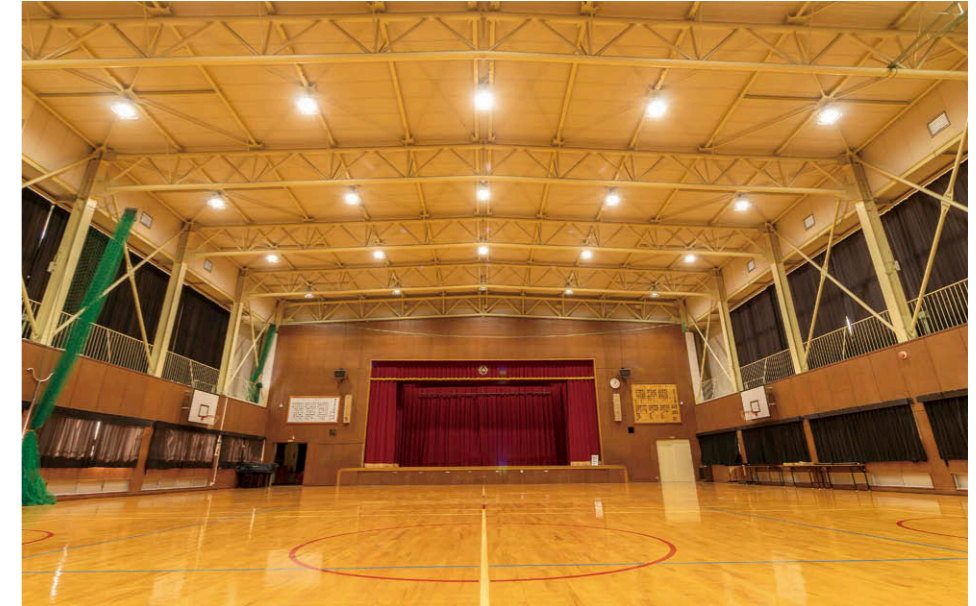
津名東小学校体育館の照明 400W形メタルハライドランプ器具に相当する明るさのLED高天井器具③を30台採用。特に児童の安全対策を徹底して平日に施工。
