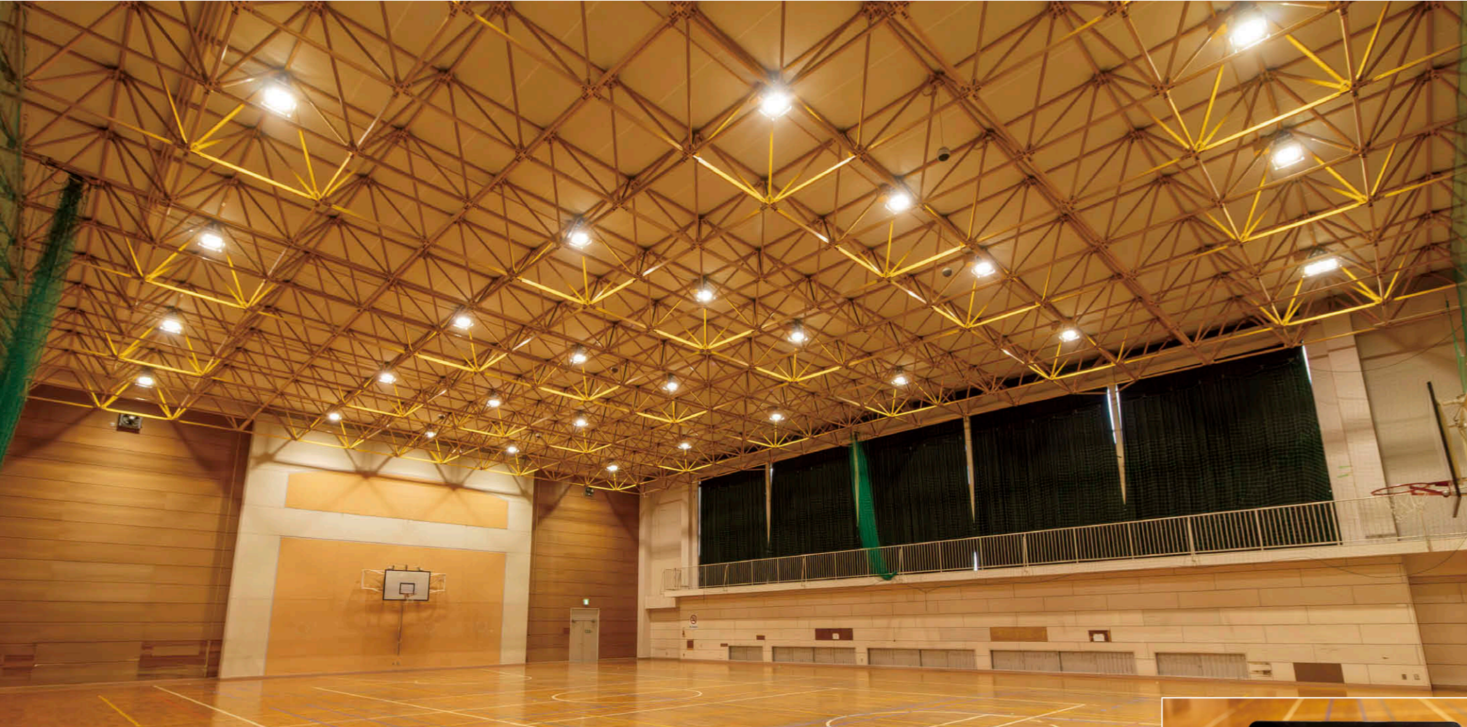
津名東小学校体育館の照明 400W形メタルハライドランプ器具に相当する明るさのLED高天井器具③を30台採用。特に児童の安全対策を徹底して平日に施工。
