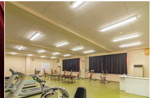
津名体育センタートレーニングルームの照明 4,000lmタイプのLEDベースライト⑤を16台採用。
