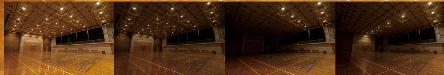
津名体育センターの照明 明るさの異なる3種類のLED高天井器具①②③を5×6列で配置し、650ルクスを超える平均照度(実測値)を実現。写真は100%全点灯(大写真)、50%調光、25%調光、入口側2列50%点灯、個別制御によるT字点灯(小写真左から)。
