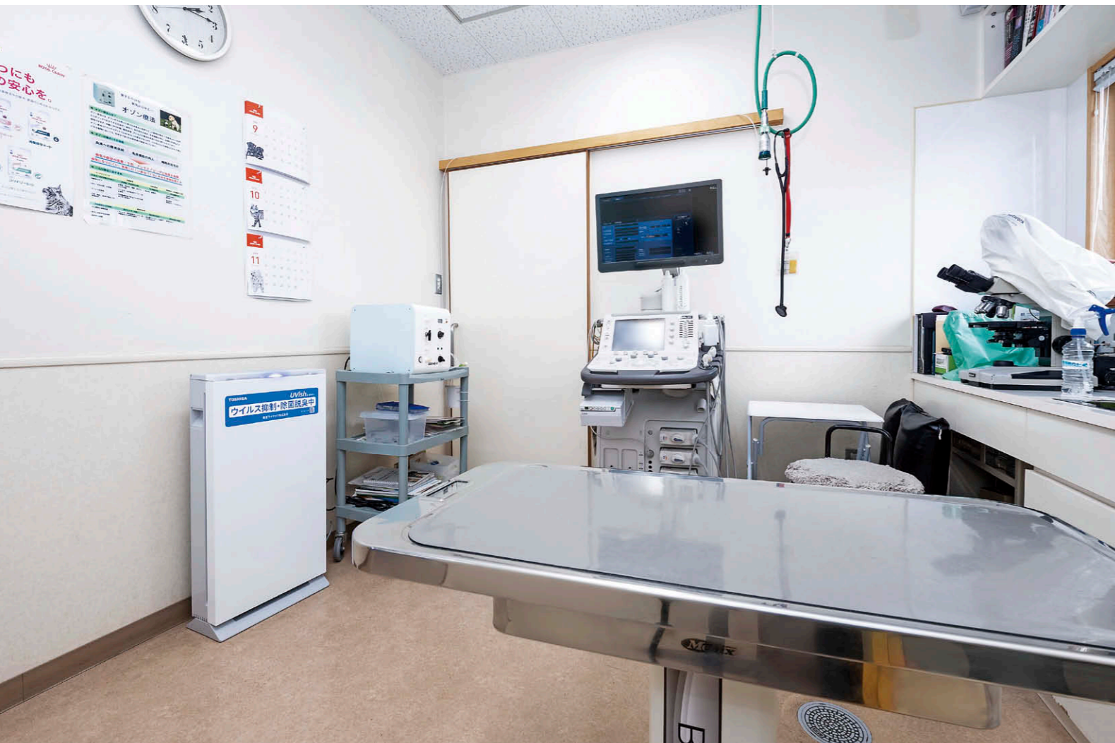
診察室での設置状況 機械音を嫌う動物に配慮して、UVish据置タイプ100をできるだけ診察台から離して設置。
