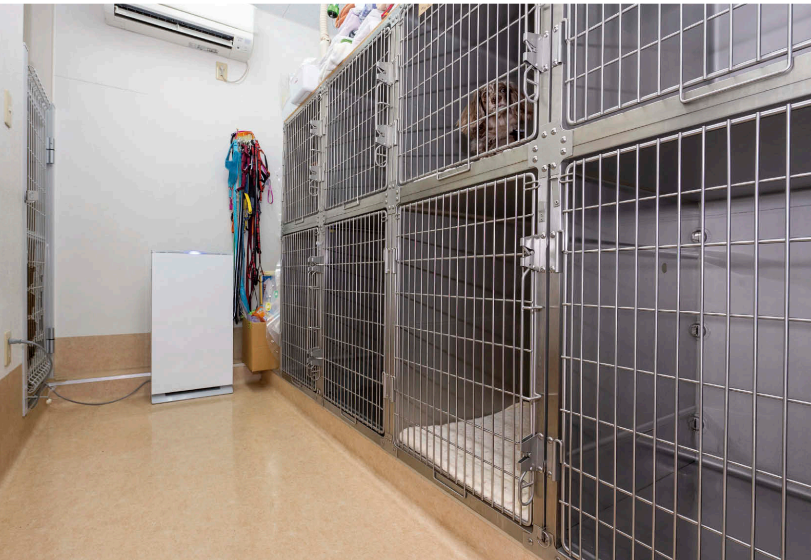
犬舎(イヌの入院室)での設置状況 狭いスペースでも薄いボディで邪魔になりにくいUVish据置タイプ100を導入。
