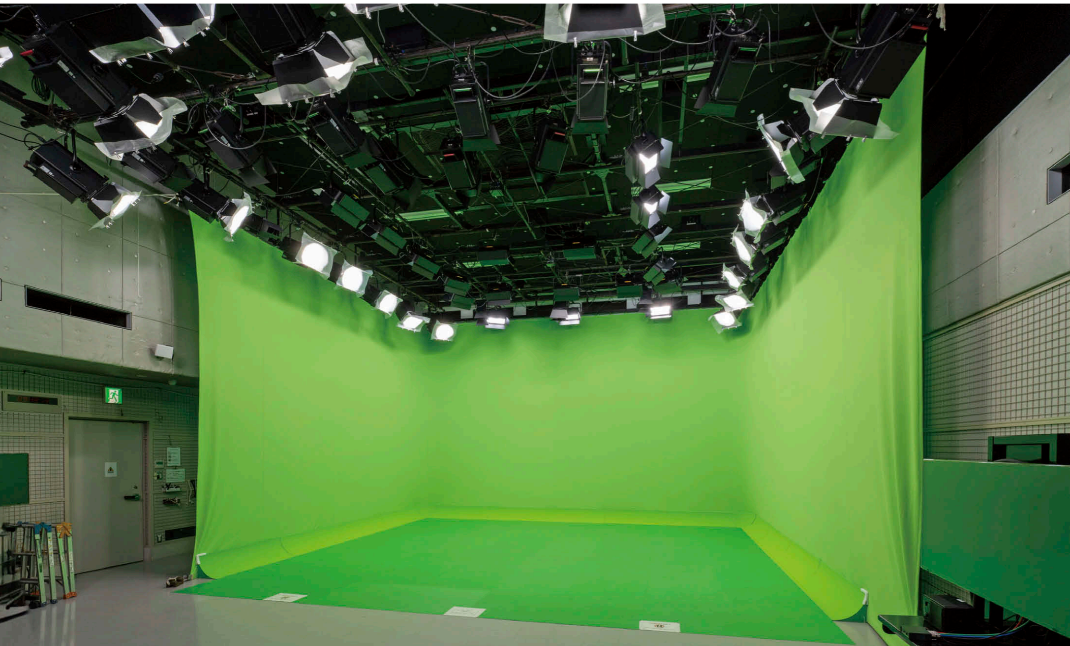
グリーンバック使用時 バーチャルスタジオとして空間全体に光が満ちるようLEDスポットライト①②、LEDブロードライト③④をプリセット。
