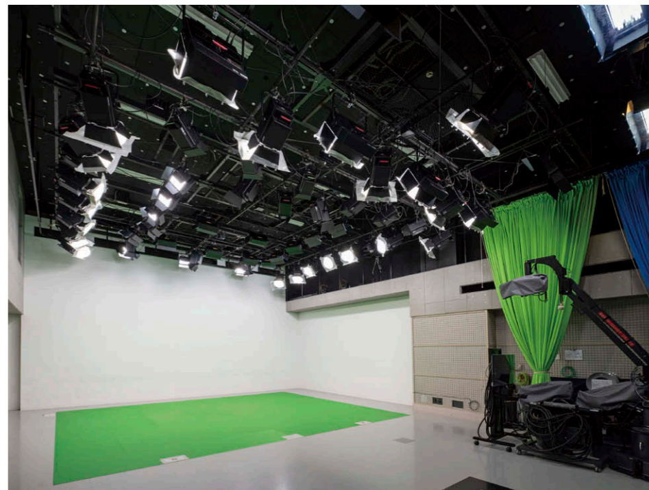
水平使用時 LED照明器具①②③④は5000Kに統一。美術セットの持ち込み収録にも対応。
