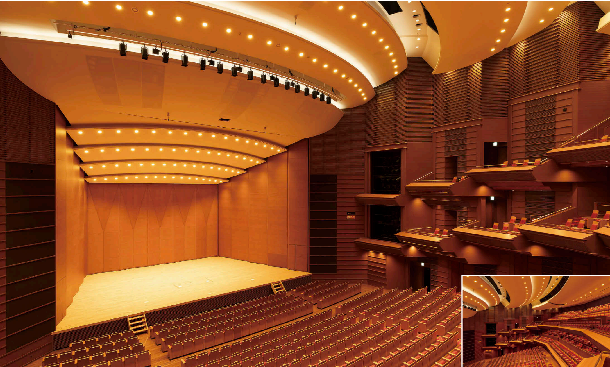
大ホール(音響反射板使用時) 客席および音響反射板の天井に、用途に合わせて「調色モード」と「単色モード」が選べるLEDシアターシリーズダウンライト①②③を採用。
