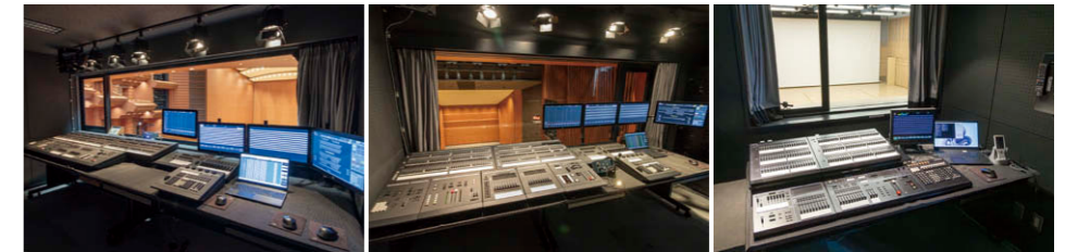
調光室 大ホール(左)と第1小ホール(中)の調光操作卓には出力4,096チャンネルのLICSTAR-V TypeSを、第2小ホール(右)はTOLSTARIII TypeFを採用。
