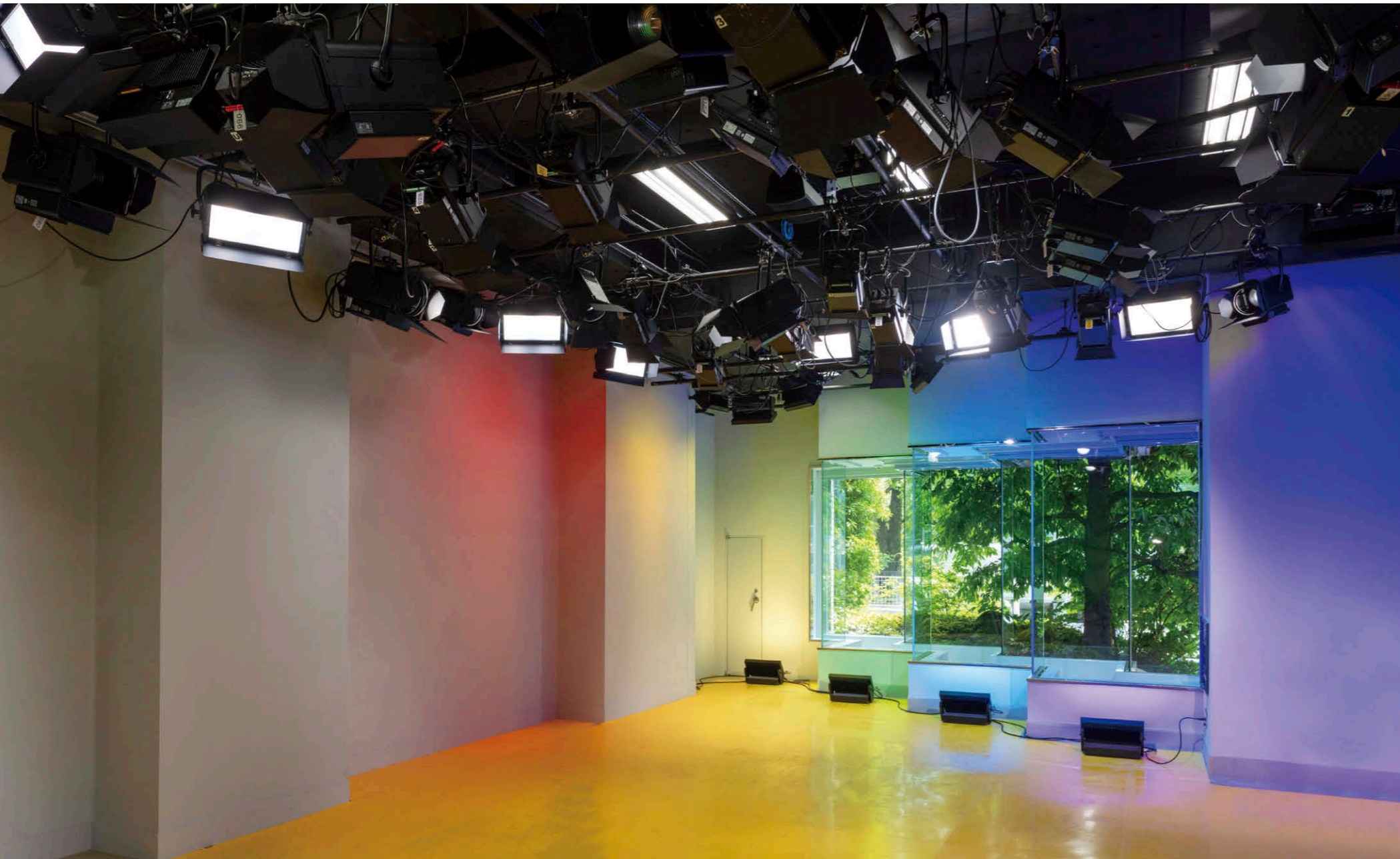
第1スタジオ 照明器具はLEDスポットライト①②、LEDブロードライト③、LED水平ライト④⑤などを採用。汎用性の高い照明演出が可能で、「5時に夢中!」などを放映。
