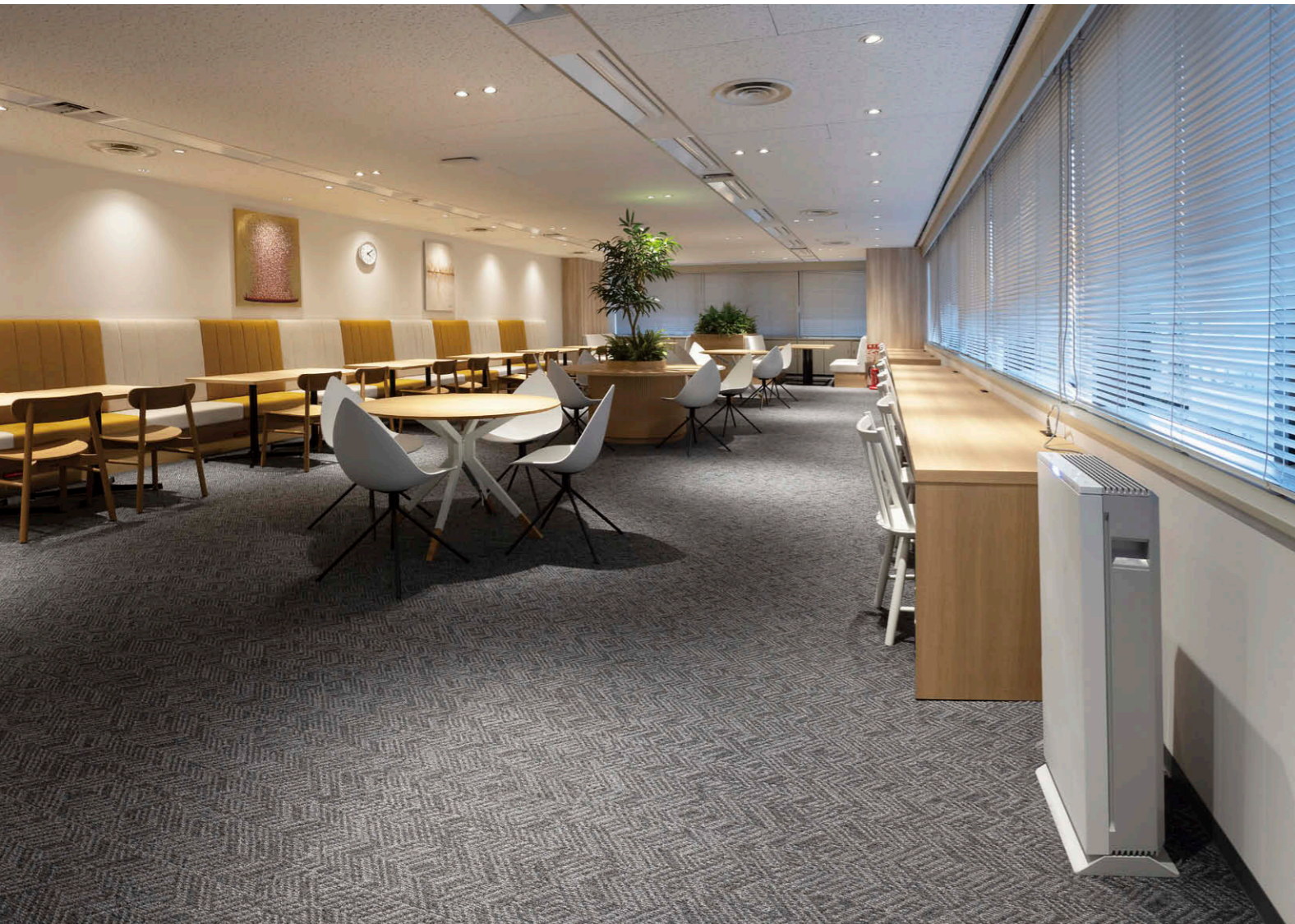
5階ラウンジ UVish据置タイプ100②を設置。空間デザインに合わせて陰影効果をつけたダウンライト④⑤によりリラックス空間を創出。
