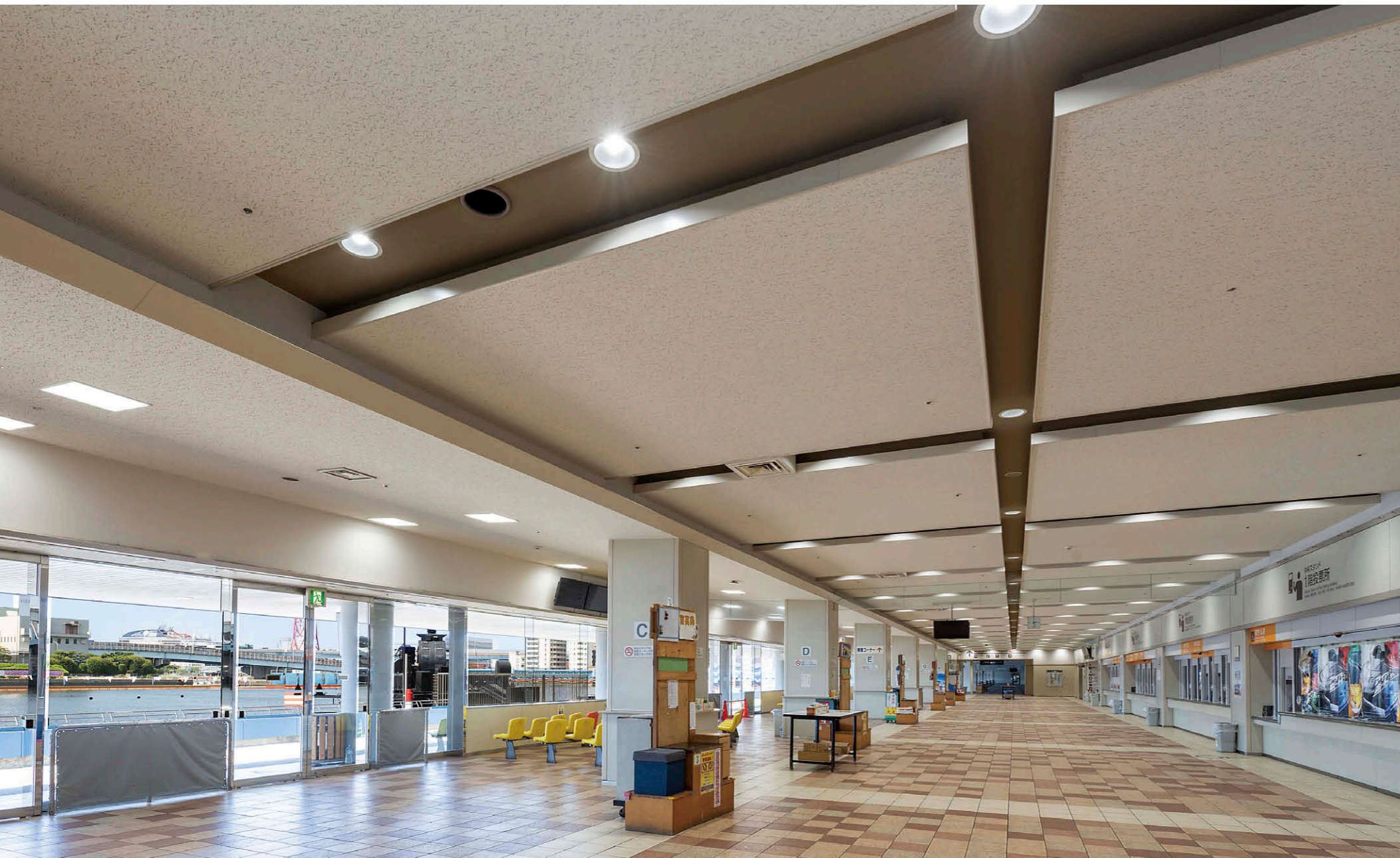
競走水面側観覧席および投票所前の照明 高さ3.5mの器具設置高さで、右側の投票所前のスペースにはLEDダウンライト①を5×19で計95台、左側の観覧スペースにはLEDスクエア器具⑤を2×16で計32台採用。
