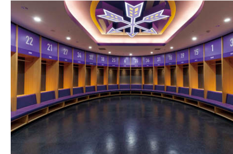
1階チーム更衣室 折上げ天井部にLEDライン器具③を、取り囲むようにLEDダウンライト②を配置。
