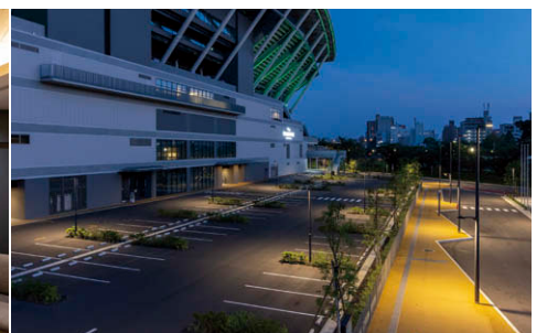
西側駐車場 400W形水銀ランプ器具相当のLED街路灯⑨を中心に採用。
