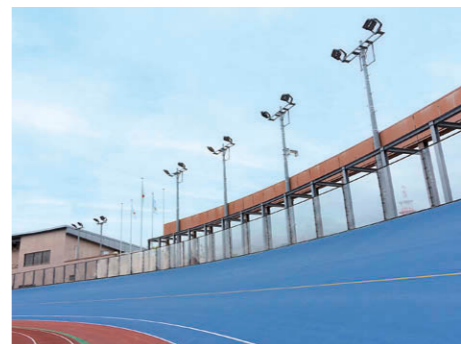
バンザマスト上部に設置し、バンクを照射。(左写真：第1〜2コーナー/右写真：第4コーナー) 競輪競技時に点灯し、ほぼ真下向きへの照射と、追跡照明手法で、競輪選手へのグレアを軽減。
