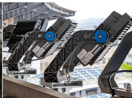
出幅の短いルーバーのため、隣り合う器具への干渉が少ない。全数のLED投光器に取付。
