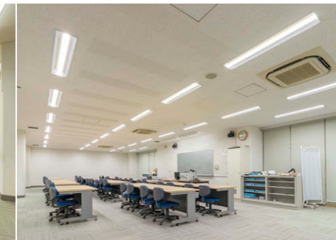
コンピュータ室の照明 グレア抑制タイプのLEDベースライト⑤を31台採用。
