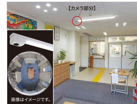
教室前廊下の照明 既設の間接照明に換えてLEDコーナー灯⑥を16台設置。
