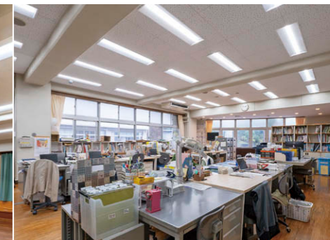
職員室(大窪小学校) LEDベースライト②とLEDダウンライト④による照明。
