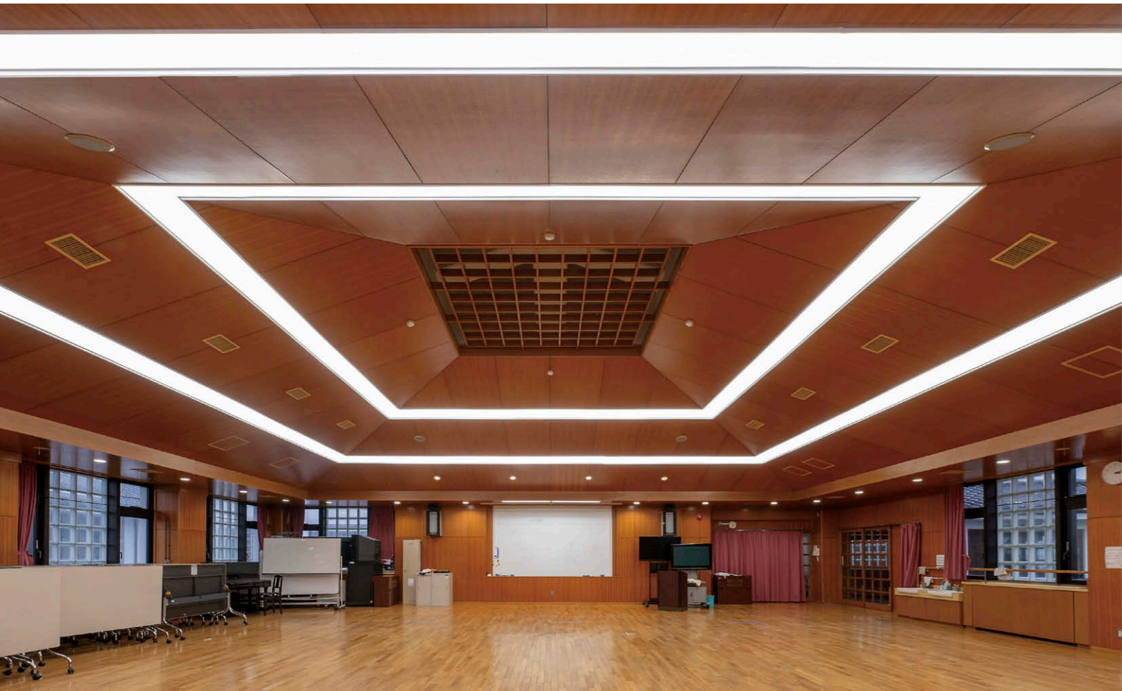
ふれあいホール(三の丸小学校) LEDベースライト②による照明。
