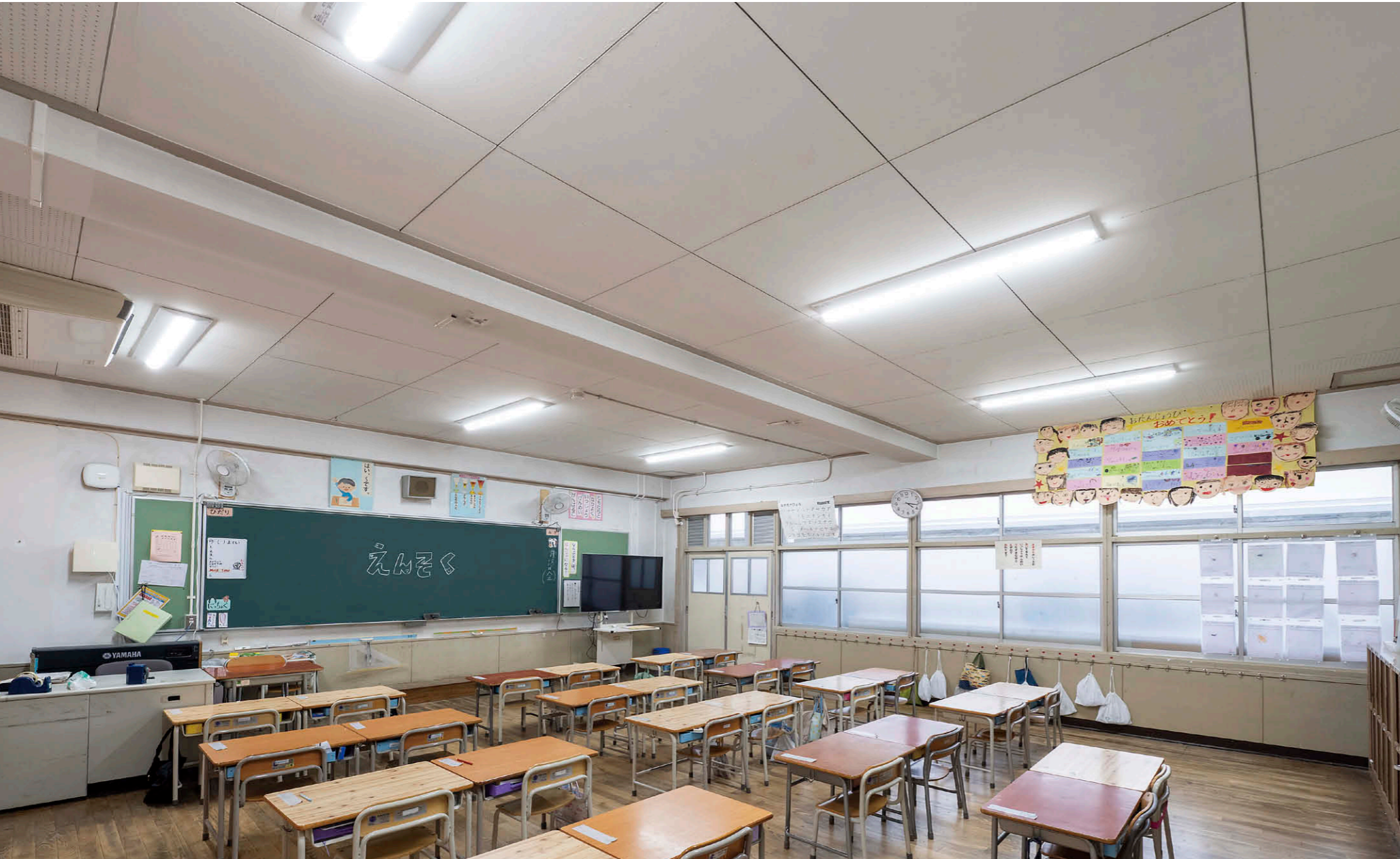
大阪市西区にある明治小学校(モデル校)普通教室の照明 パイプ吊りの既設2灯用蛍光ランプ器具(設置高さ2.25m)を、直付タイプ(設置高さ2.75m)のLEDベースライト6,900lmタイプ①に更新、均斉度を高めるとともに500ルクスを超える机上面平均照度を確保。
