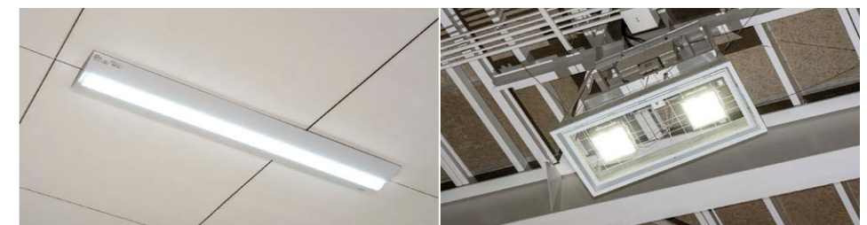
普通教室に採用された直付形LEDベースライト① 体育館に採用されたLED高天井器具②
