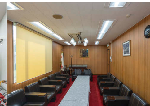
会議室 TENQOOシリーズを採用し、リニューアルプレートを用いて旧器具の設置跡をカバー。
