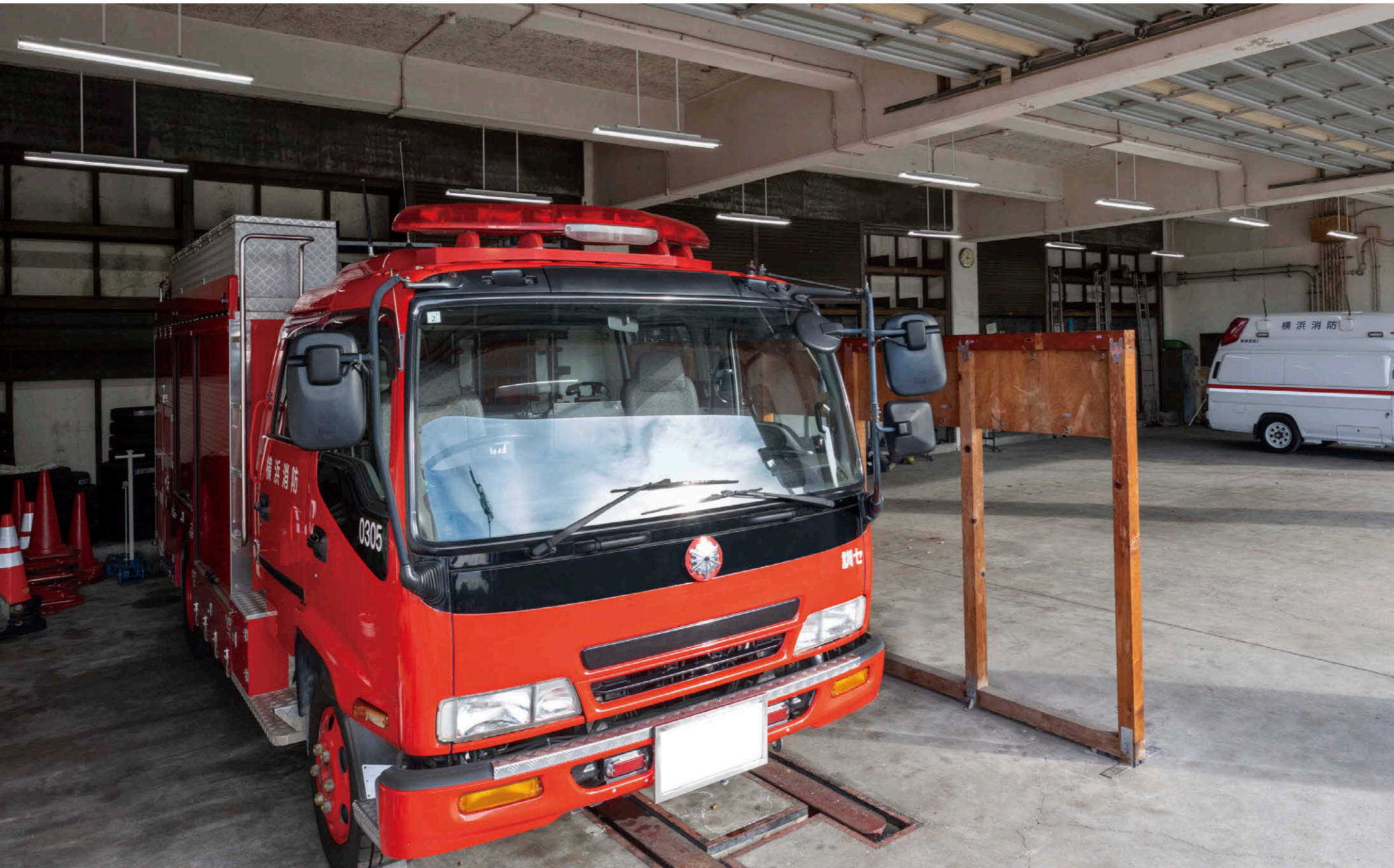
ガレージ LEDベースライトTENQOOシリーズ反射笠器具①を採用し、吊金具も新しいものに更新。
