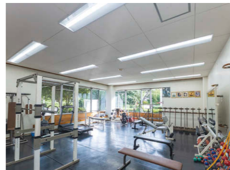
トレーニング室 TENQOOシリーズ埋込形の連結用器具③を2台連結で配置。
