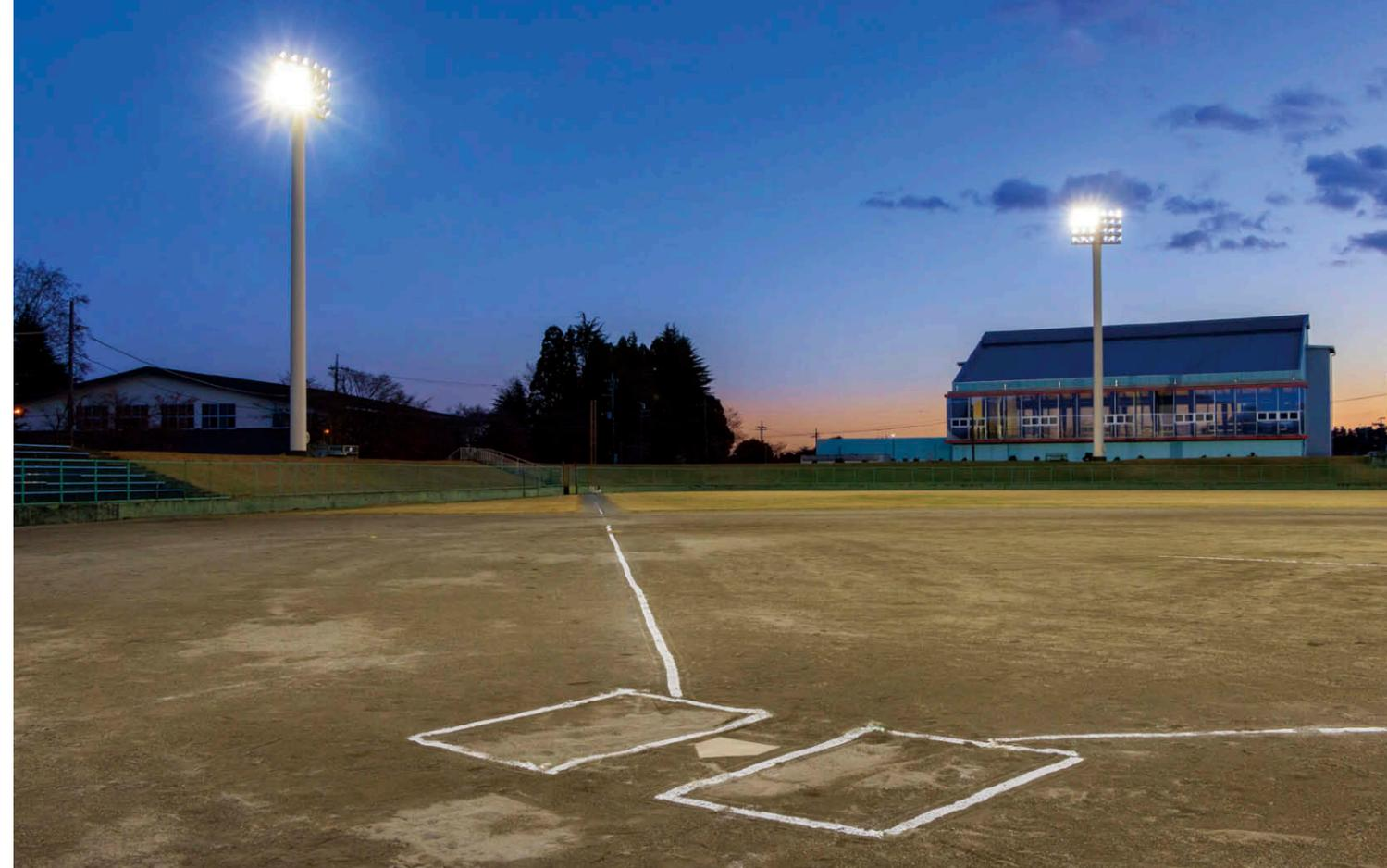
軟式野球場(ホームベース側からアリーナ方向を臨む) LED投光器中角形①132台とLED投光器広角形②12台によりグラウンド全体をムラなく照射。
