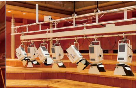
コンサートホールの照明バトン 2本の美術バトンを照明バトンに変更した上でさらに1本増設。更新されたLEDスポットライト⑤⑥は特注仕様様のアイボリー塗装色。
