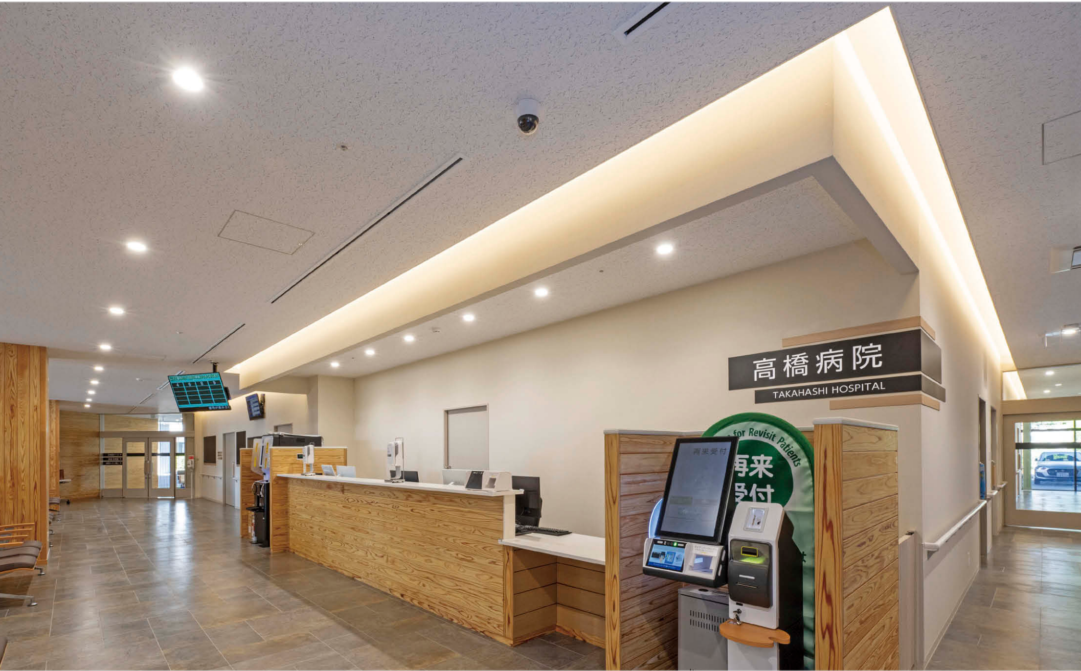
総合受付 4000KのLEDユニット交換形ダウンライト①とLED屋内用ライン器具②の間接照明により、あたたかみのある落ち着いた空間を創出。
