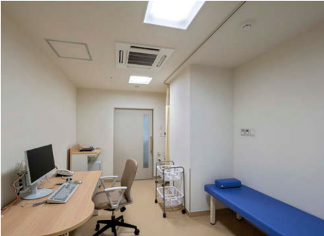
診察室 まぶしさに配慮し、グレア抑制タイプのLED一体形スクエア器具⑤を採用。
