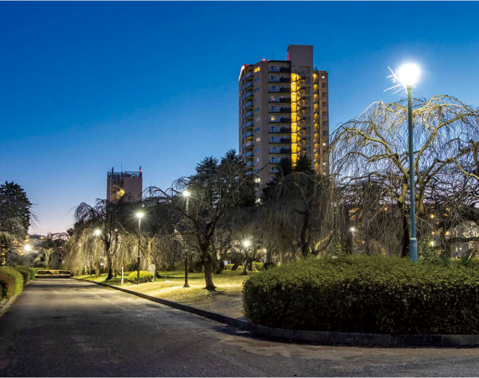
榴岡公園 園路沿いのLED公園灯①②による照明。
