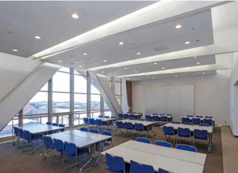
609会議室 主照明にLEDダウンライト⑥、間接照明にTENQOOシリーズ⑦を採用。
